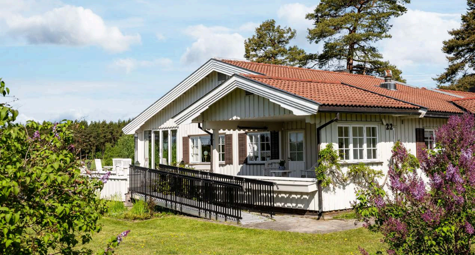
Utvendig rampe til delvis overbygget veranda.
