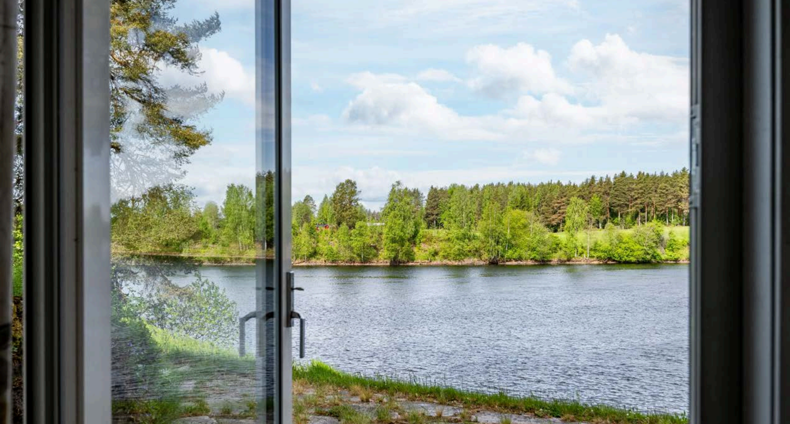
Terrassedør fra 2008 ut til vestvendt uteplass belagt med steinheller.
