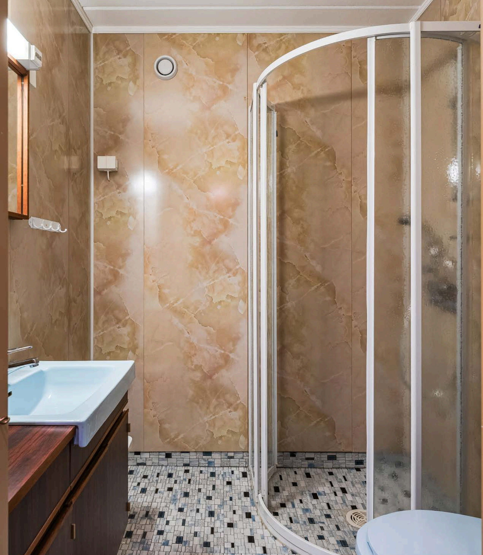
Eldre baderom i hybeldelen med mosaikkfliser på gulv, elektriske varmekabler og våtromsplater på veggene.
