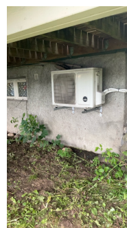
Viktig å lede vann fra varmepumpen bort fra grunnmuren.
