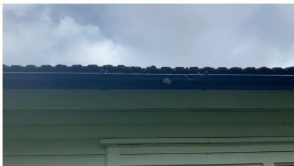
Flassing på takrenner/beslag.
