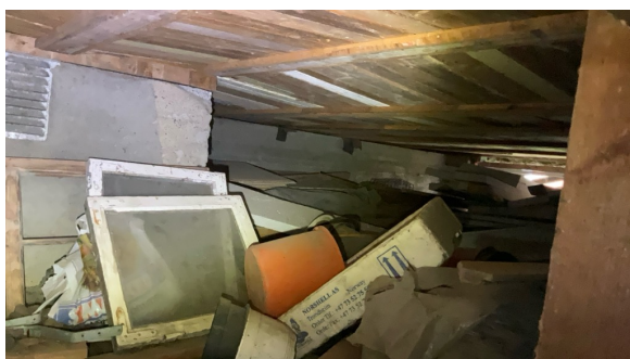
Kryp kjeller ble besiktiget innvendig med stikktakninger.
