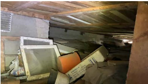
Kryp kjeller ble besiktiget innvendig med stikktakninger.
