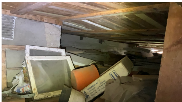
Kryp kjeller ble besiktiget innvendig med stikktakninger.
