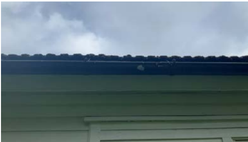
Flassing på takrenner/beslag.
