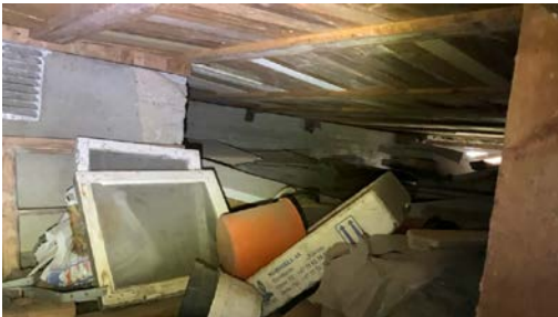
Kryp kjeller ble besiktiget innvendig med stikktakninger.
