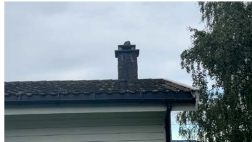
Det er ikke montert pipebeslag. Ved manglende beslag er det fare for at vann trenger inn i takkonstruksjon og kan føre til fuktproblemer, som igjen kan forårsake mugg og råte.
