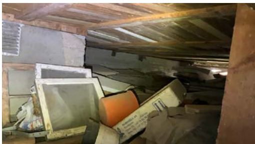
Krypkjeller ble besiktiget innvendig med stikktakninger.
