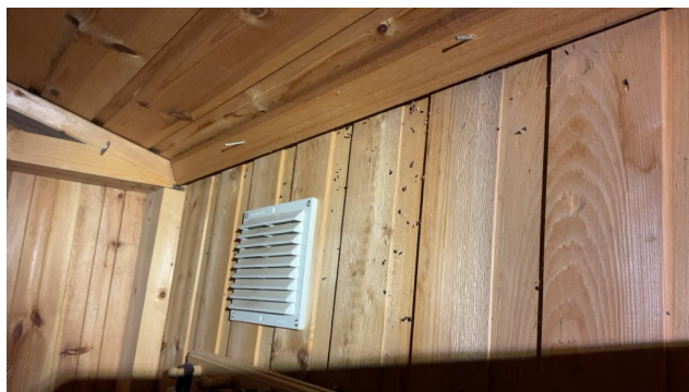
Glipper i overgang vegg og setningskader i bygning med skjevheter i konstruksjoner som årsakssammenheng
