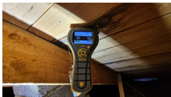
Ingen forhøyde fuktverdier ble registrert ved befarings.
