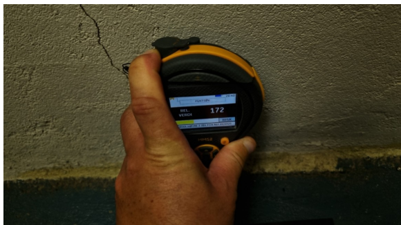
Fuktmåling i rom under terreng.
