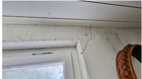
Innvendig sprekk.
