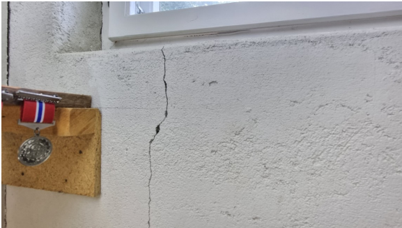
Innvendig sprekk.
