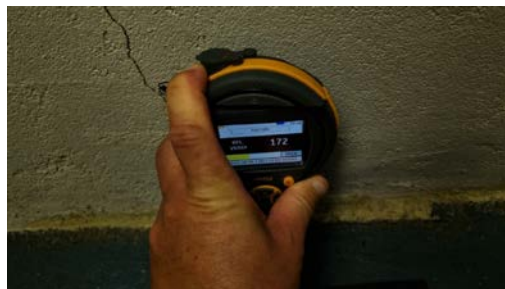
Ingen unormale fuktverdier ble registrert ved befarung, men rom under terreng kombinert med drenering/fuktsikring er å anse som en risikokonstruksjon
