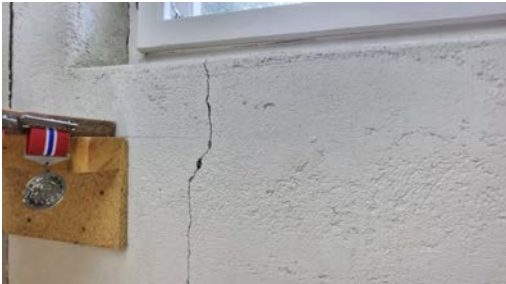
Innvendig sprekk.
