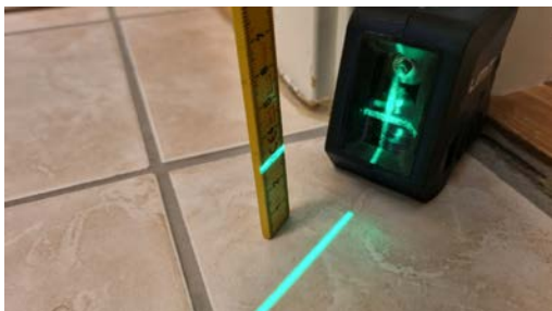
Kontroll av fall.
