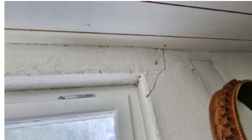
Innvendig sprekk.
