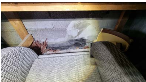
Ingen synlig oljetank/dagtank.
