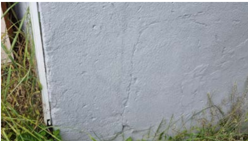
Utvendig sprekk.
