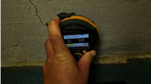
Fuktmåling i rom under terreng.
