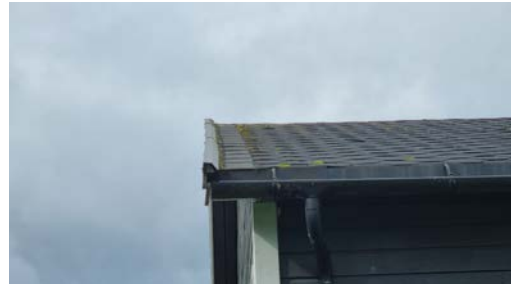
Det er lagt en remse med nyere takpapp.
