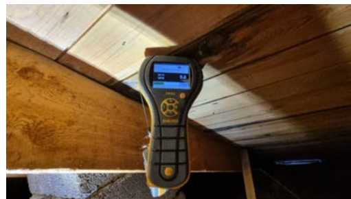
Ingen forhøyde fuktverdier ble registrert ved befarings.
