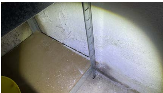
Bod/teknisk rom ved garasjen.
