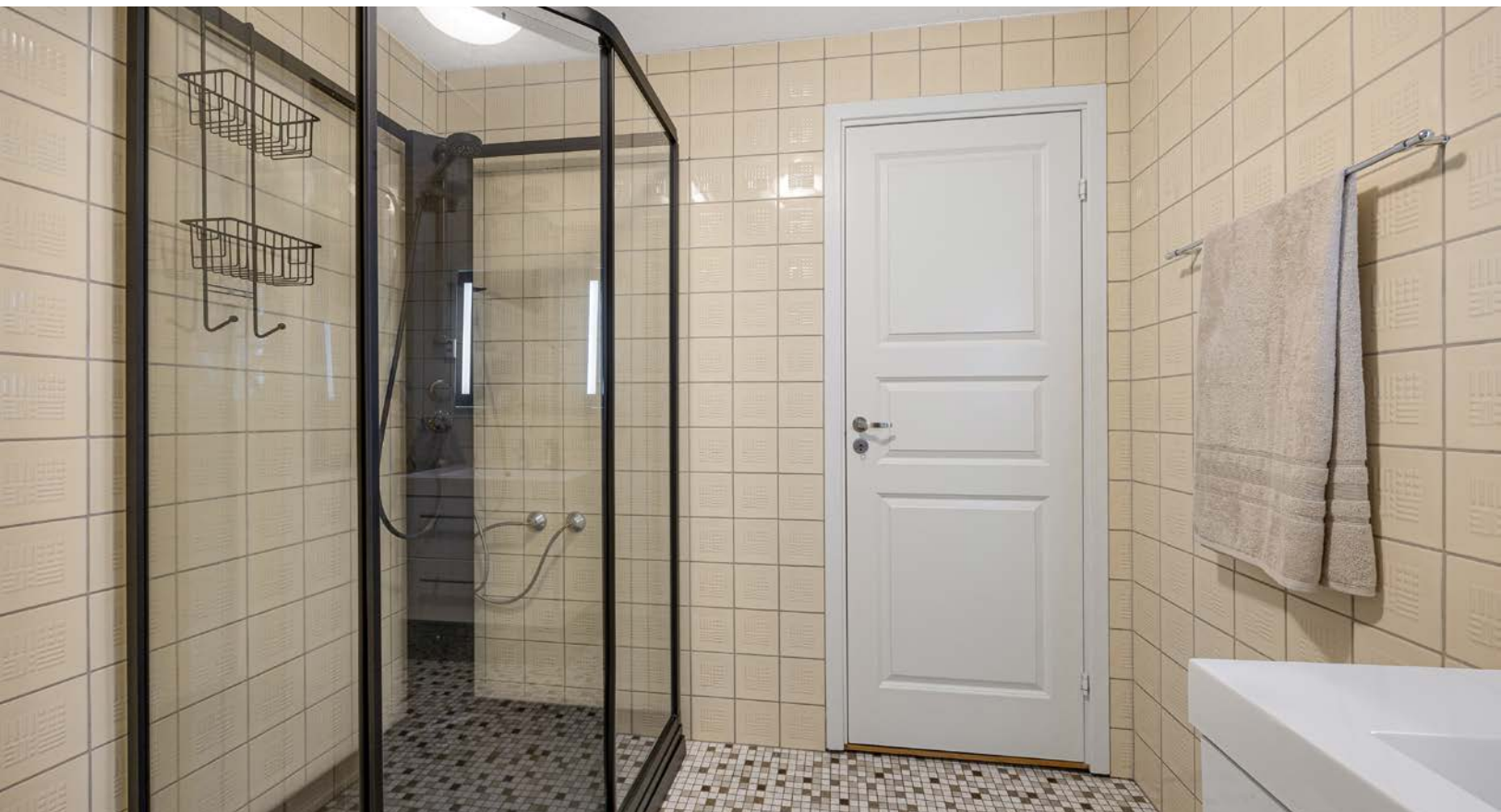
Videre har badet en radiator, et toalett, mekanisk avtrekk og et dusjkabinett.
