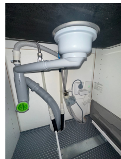
Røropplegg i kjøkkenbenk med Waterguard hybel
