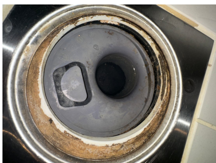
Sluk i plast, plassert i dusjnise
