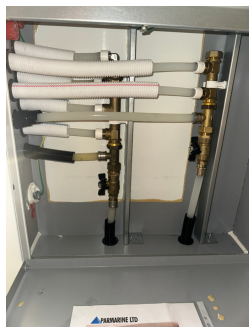
Samleskap med rørkurser og stoppekraner hybel
