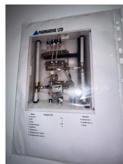
Kursoversikt for rør i samleskap leilighet
