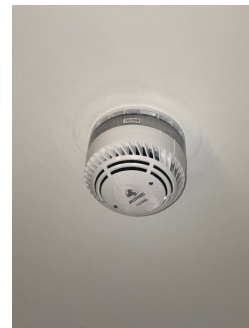
Røykvarsler med optisk sensor
