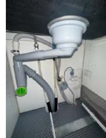
Rørøpplagg i kjøkkenbenk med Waterguard hybel
