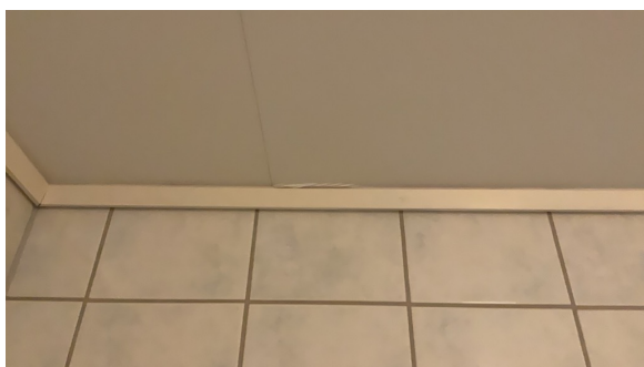
Folie slipper i kanter på himlingsplater
