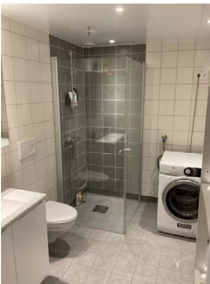
Dusj, wc og opplegg for vaskemaskin.
