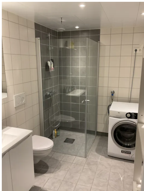
Dusj, wc og opplegg for vaskemaskin.
