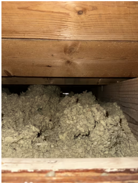
Tiltenkt luftespalte ved raft er noe redusert pga isolasjon.
