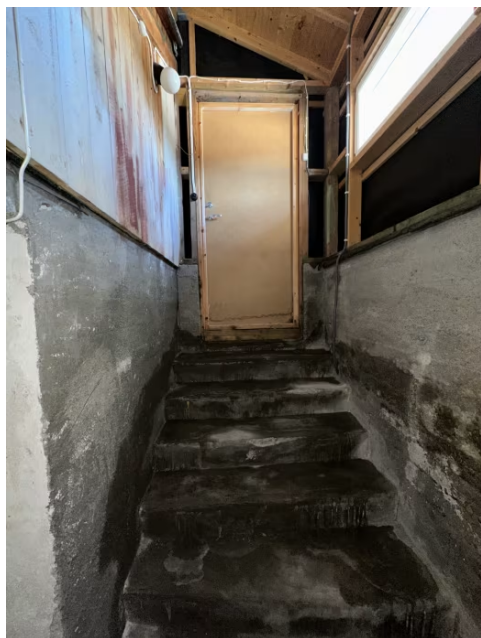
Viser betongtrapp fra terreng til kjeller/underetasje.
