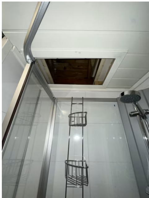
Adkomst til kaldtloft via luke over dusjkabinett på badet. Begrenset adkomst for inspeksjon.
