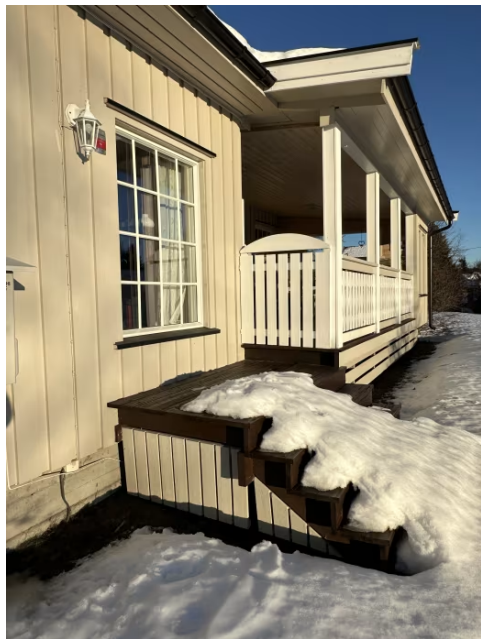
Viser terrengtrapp ved terrasse.
