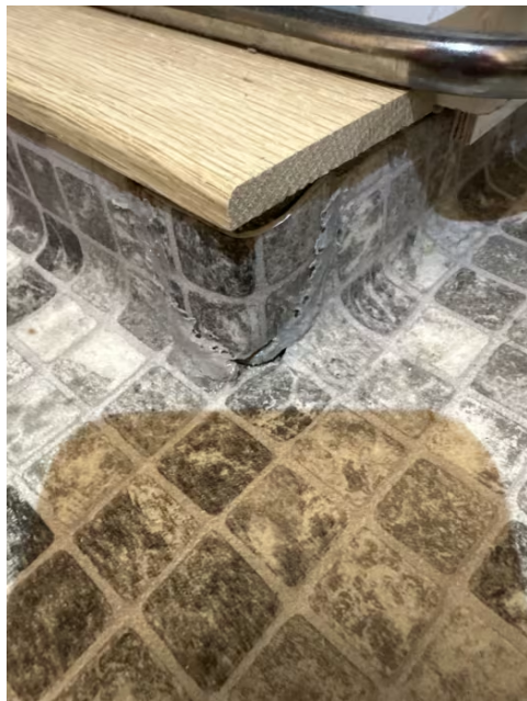
Viser sprekke i hjørne ved oppbrett av belegg.
