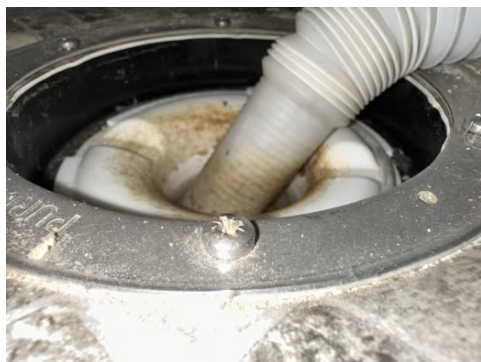
Viser plastsluk med synlig belegg under klemring.
