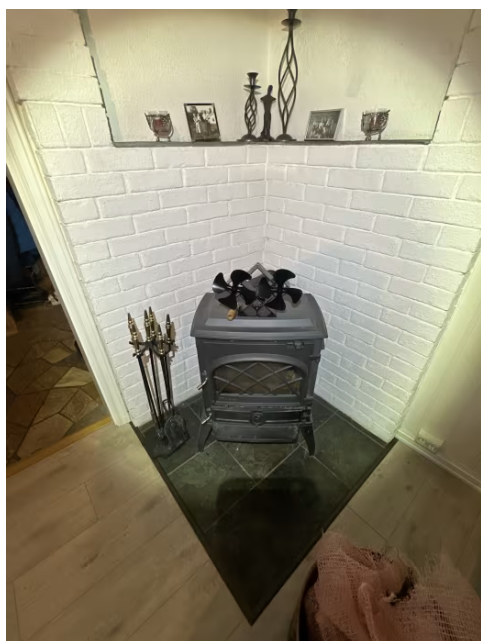
Viser vedovn i stue 1.etasje.
