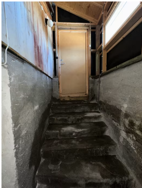
Viser betongtrapp fra terreng til kjeller/underetasje.
