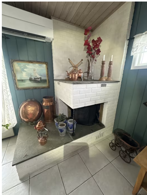
Viser peis i peisestue 1.etasje.
