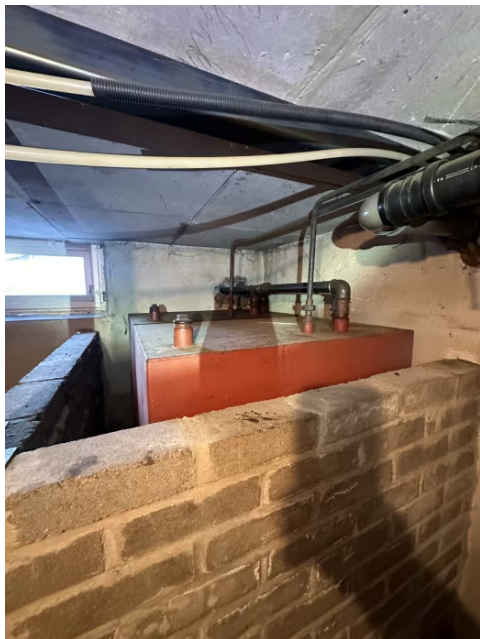
Viser innmurt oljetank i kjeller.
