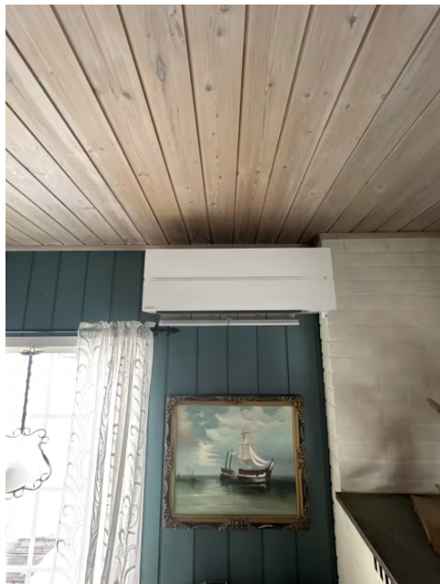
Innedel montert i peisestue.
