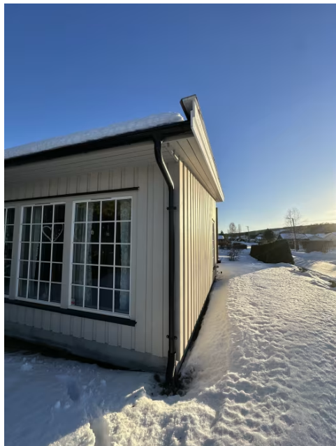
Taknedløp ført med drensledning til grøft ved veg.
