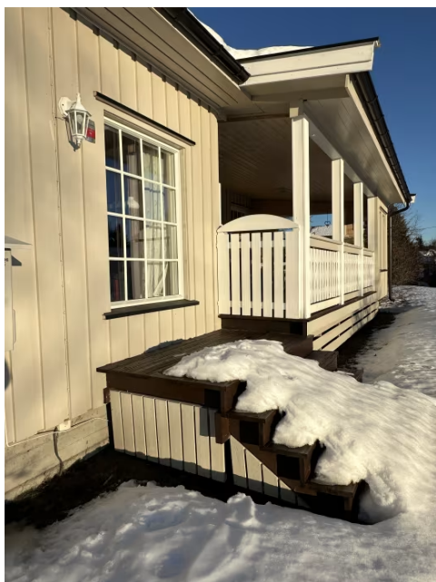
Viser terrengtrapp ved terrasse.
