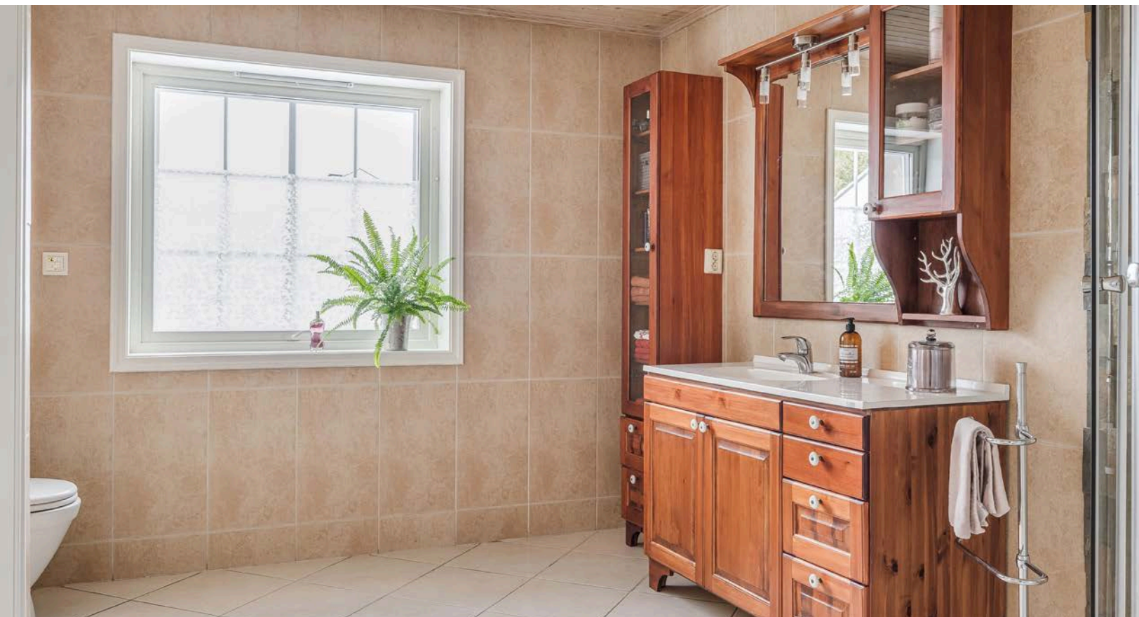
Stort og lyst baderom i 1. etasje som ble pusset opp i 2003. Takstmann opplyser om behov for renovering av badet.
