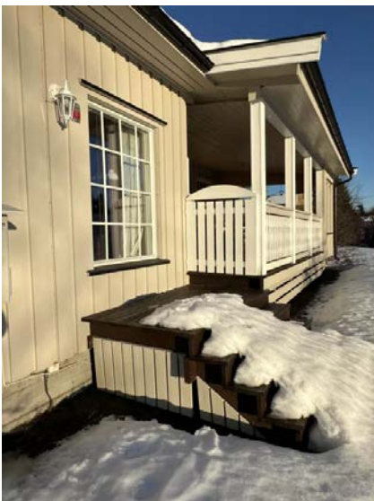
Viser terrengtrapp ved terrasse.
