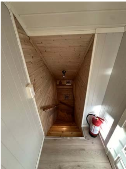
Viser trapp mellom 1 og 2.etasje. Noe lavt ved ganghøyde.
