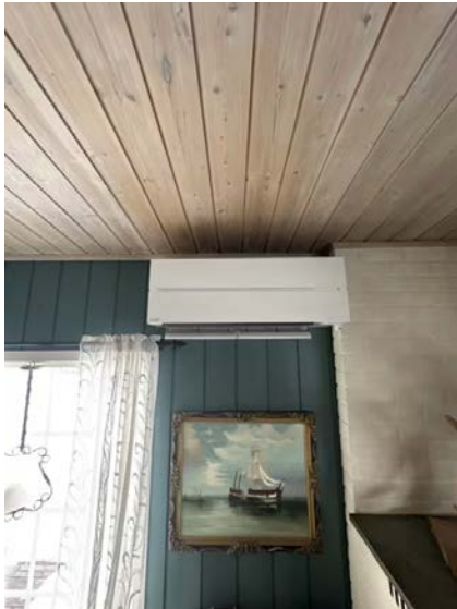
Innedel montert i peisestue.
