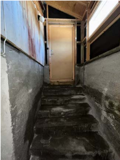
Viser betongtrapp fra terreng til kjeller/underetasje.
