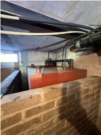
Viser innmurt oljetank i kjeller.
