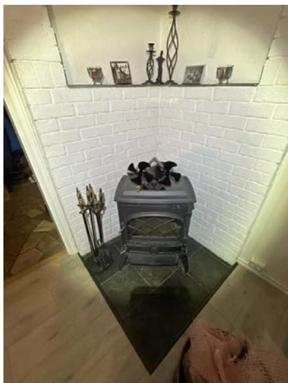
Viser vedovn i stue 1.etasje.
