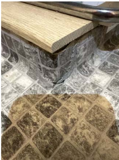
Viser sprekk i hjørne ved oppbrett av belegg.
