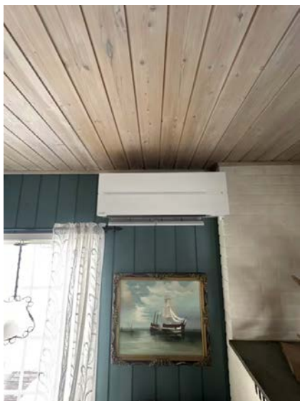
Innedel montert i peisestue.
