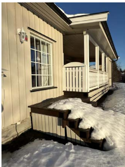
Viser terrengtrapp ved terrasse.
