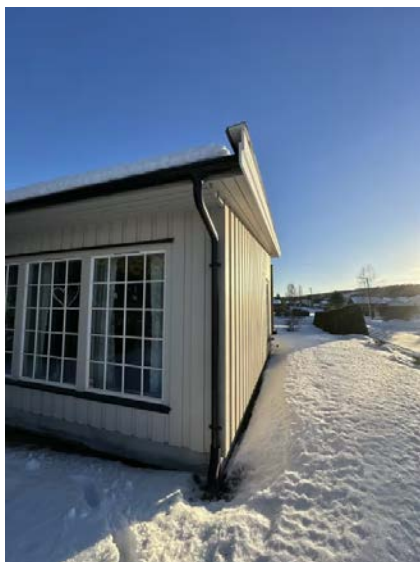
Taknedløp ført med drensløp til grøft ved veg.
