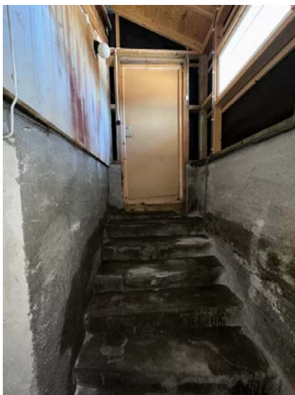
Viser betongtrapp fra terreng til kjeller/underetasje.
