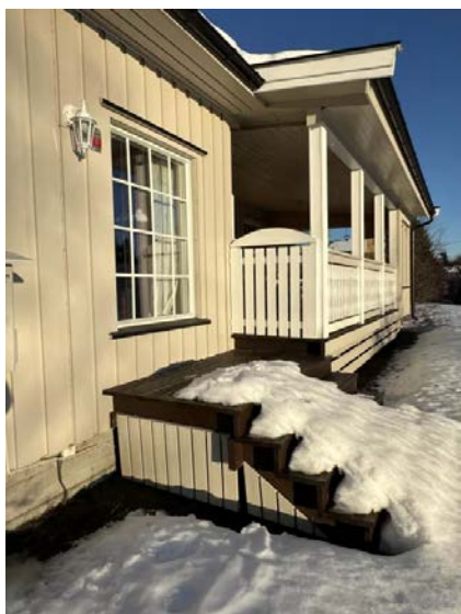
Viser terrengtrapp ved terrasse.
