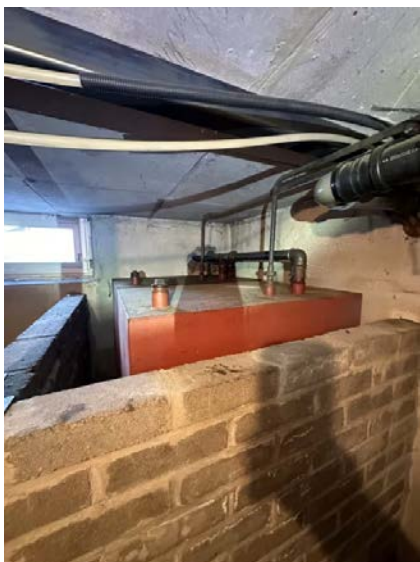
Viser innmurt oljetank i kjeller.
