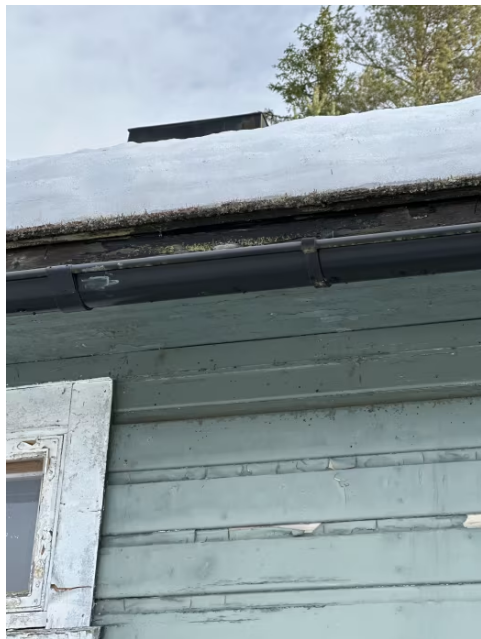
Forkantbeslag i overgang takfot og ned mot renne er ikke montert. Råteskader registreres.
