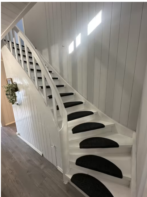
Viser trapp mellom 1 og 2.etasje
