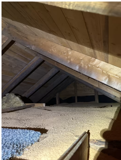
Viser loft isolert med sagflis.
