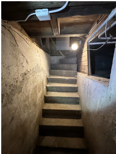
Viser betongtrapp til kjeller.
