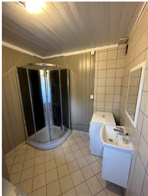
Viser baderomsinnredning, dusjkabinett og opplegg for vaskemaskin.
