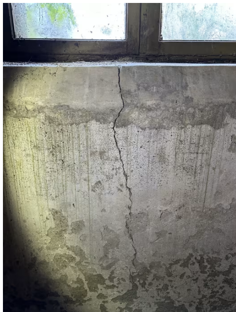
Viser sprekk i grunnmur. Bilde tatt i kjeller.
