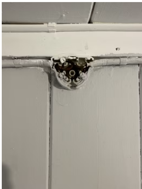
Eldre koblingssboks mangler lokk.
