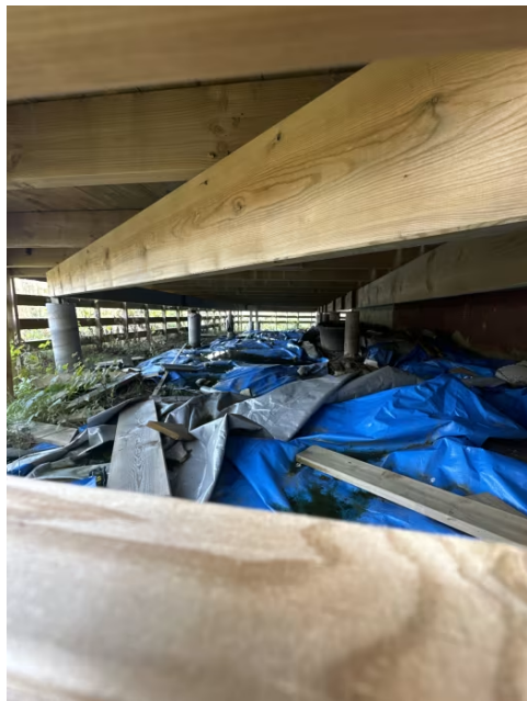
Viser søylefundamenter under terrasse.
