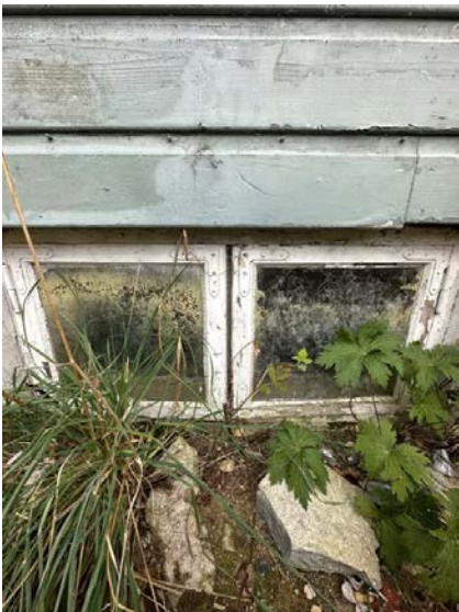
Viser varevindu i kjeller.
