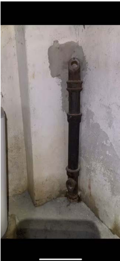
Viser eldre avløpsrør i kjeller.
