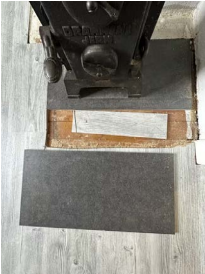
Gulv fremstår og blitt utført på egeninnsats med varierende håndverksmessig utførelse.
