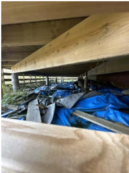
Viser søylefundamenter under terrasse.
