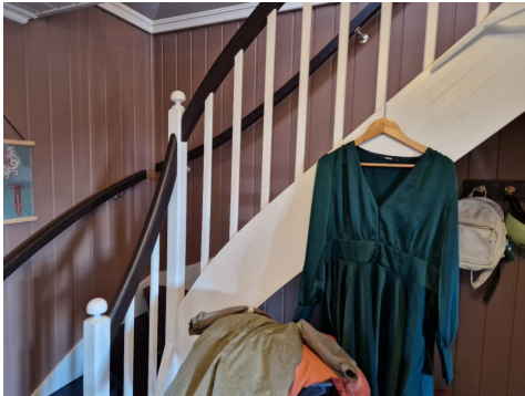
Åpninger i rekkverket er målt til over 10cm.
