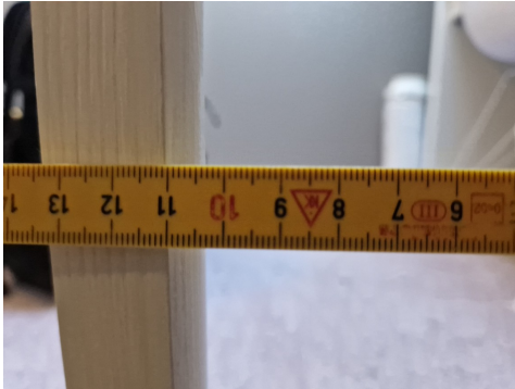
Åpninger i rekkverket er målt til over 10cm.
