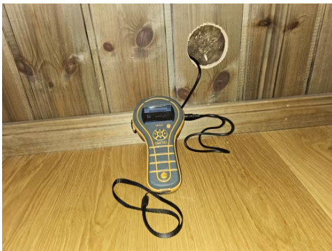
Bilde viser fuktmåling.
