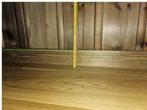
Bilde viser måling av etasjeskiller.
