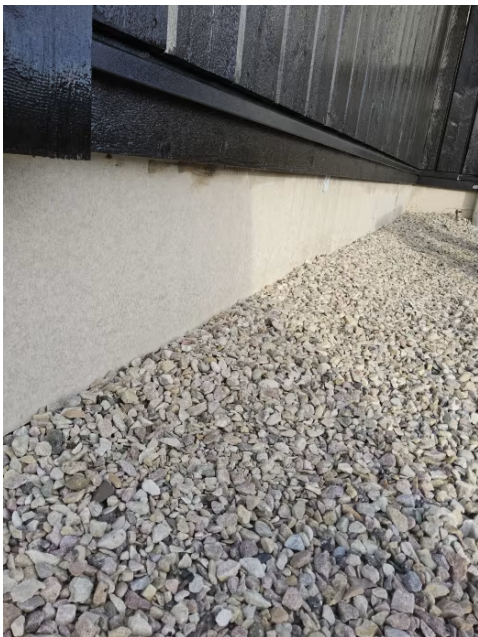
Bilde viser platekledning på grunnmur.
