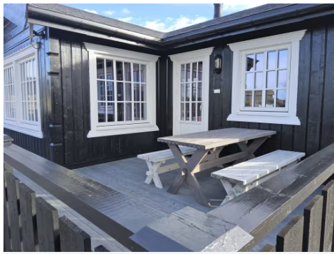
Bilde viser deler av terrasse.
