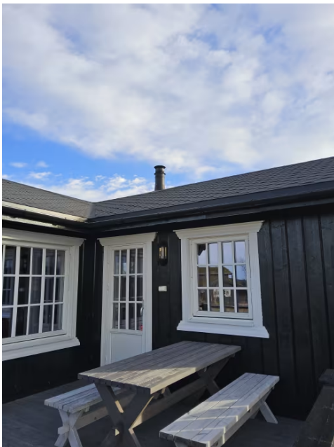
Bilde viser pappshingel og stålpipes.
