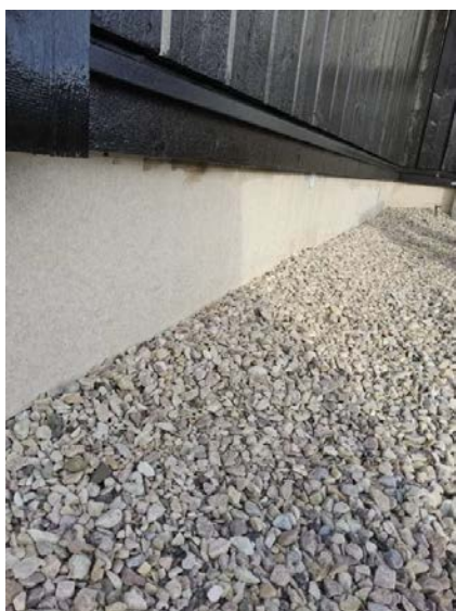
Bilde viser plateledning på grunnmur.
