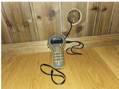
Bilde viser fuktmåling.
