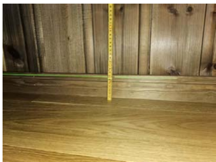
Bilde viser måling av etasjeskiller.
