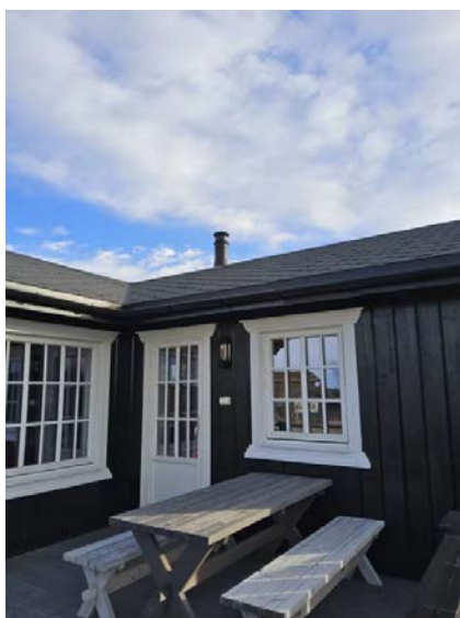
Bilde viser pappshingel og stålpipe.
