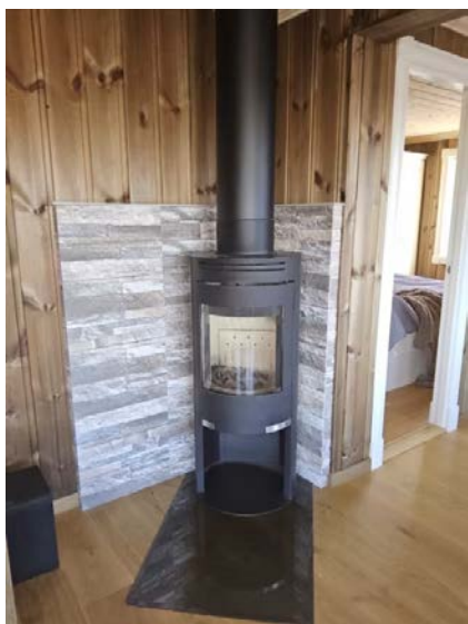
Bilde viser ildsted og deler av stålpipe.
