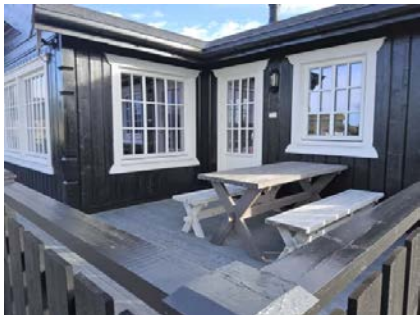
Bilde viser deler av terrasse.
