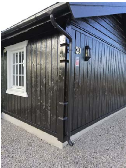
Bilde viser taknedløp.
