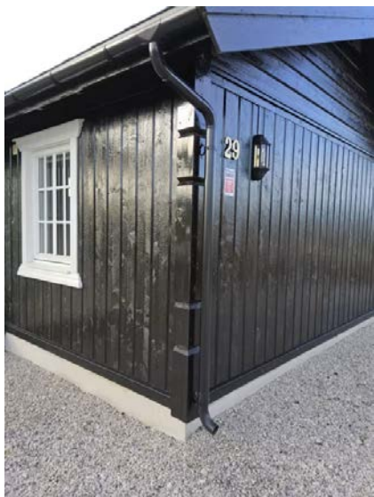
Bilde viser taknedløp avsluttet over bakken.
