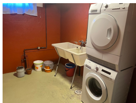
Vaskerom i kjeller.
