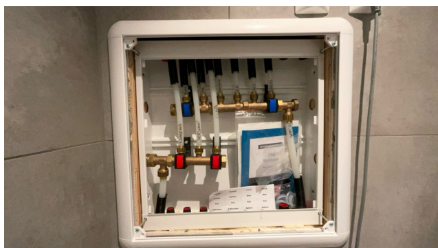
Besiktigelse av røropplegg.
