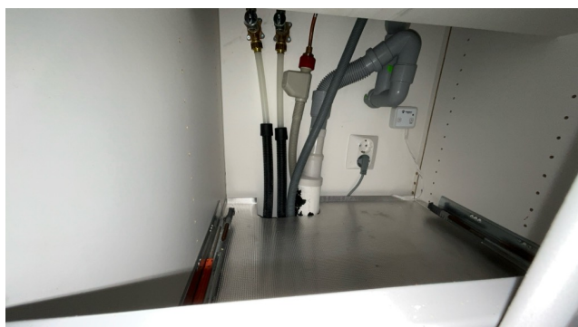
Besiktigelse av røropplegg.
