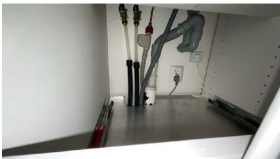
Besiktigelse av røropplegg.
