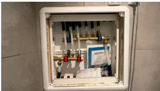
Besiktigelse av røropplegg.
