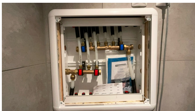
Besiktigelse av røropplegg.
