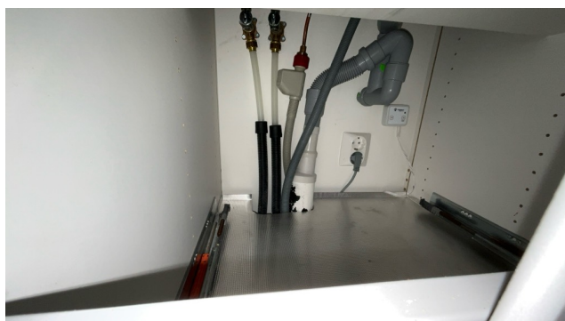
Besiktigelse av røropplegg.
