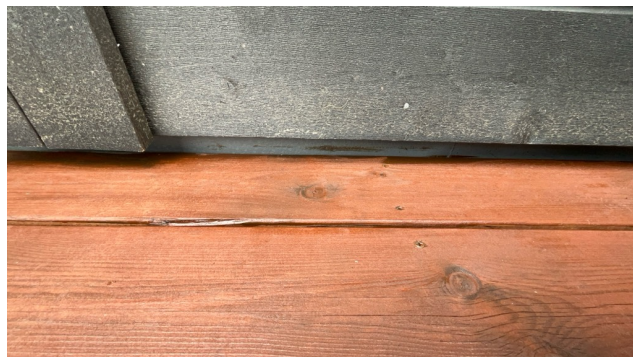
Synlig sveisemembran mot vegg i 2.etg
