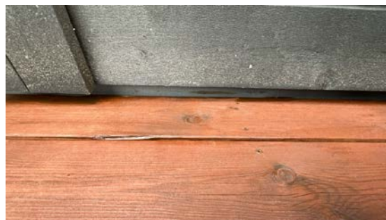
Synlig sveisemembran mot vegg i 2.etg
