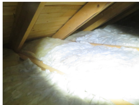
Mineralull opp mot undertak.
