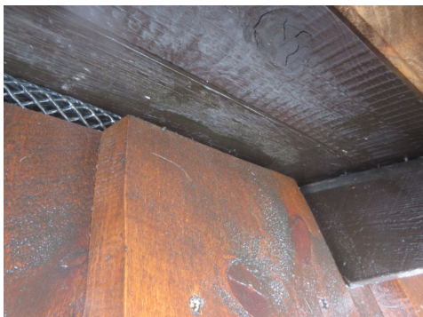
Luftespalte mellom sperrer.
