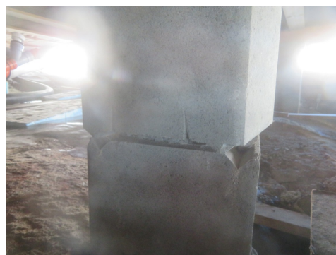
Plassbygget "skjev" pilar.
