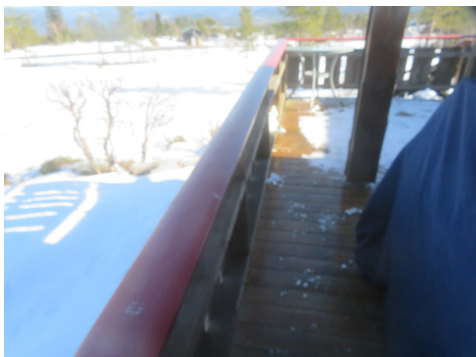
Rekkverk med lav høyde.
