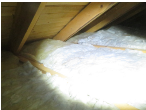
Mineralull opp mot undertak.
