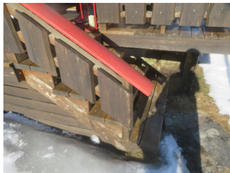
Trapp ved inngang.
