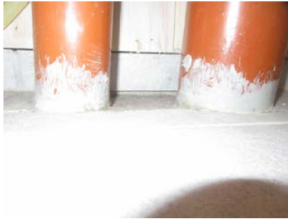
Rørgjennomføringer med synlig smøremembran.
