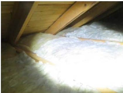
Mineralull opp mot undertak.
