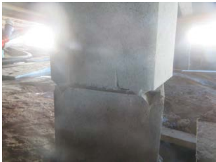
Plassbygget "skjev" pilar.
