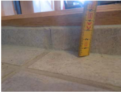
Oppkant mot dør.
