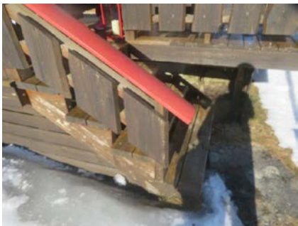
Trapp ved inngang.
