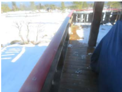
Rekkverk med lav høyde.
