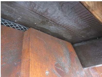
Luftespalte mellom sperrer.
