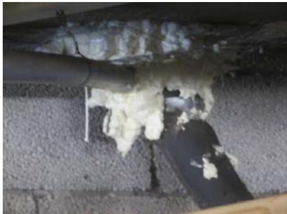
Forsøk på isolering av vann/avløp i etasjeskiller under kjøkken.
