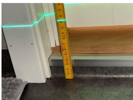
Fallforhold ca. 113 mm overkant gulv ved terskel
