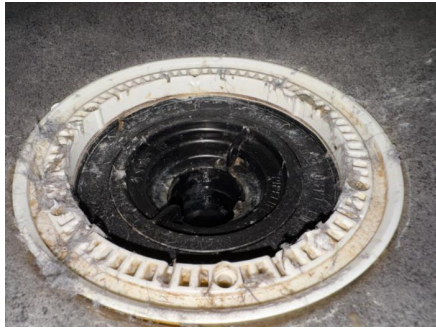
Plastsluk med klemring og synlig gulvbelegg/membran
