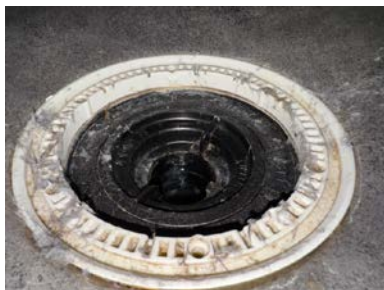
Plastsluk med klemring og synlig gulvbelegg/membran
