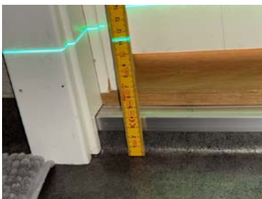
Fallforhold ca. 113 mm overkant gulv ved terskel
