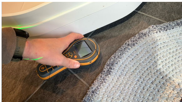
Enkle fuktsøk viste normale verdier.
