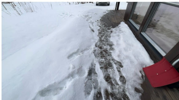
Oversiktsbilde terrasse nordvest
