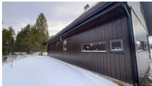
Grunnmur mot øst.
