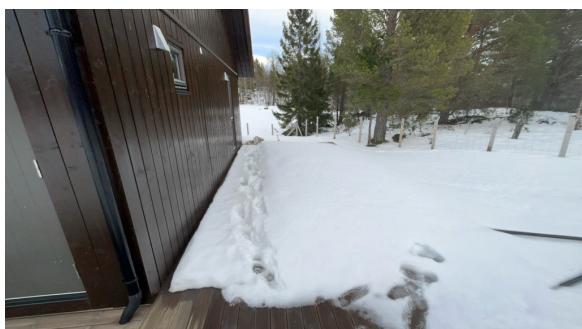
Oversiktsbilde terrasse sør
