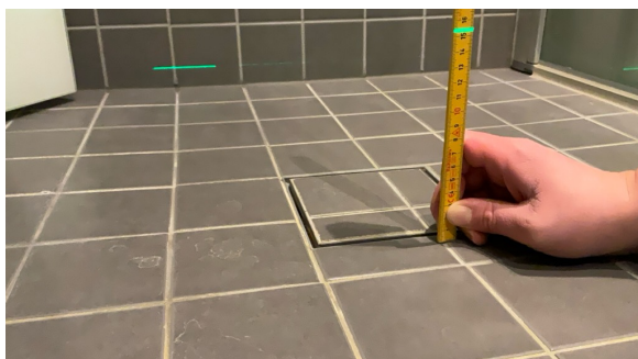
Sluk. Laser er plassert midt i rommet. Referanselinje 136 mm.
