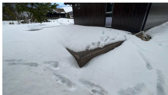
Oversiktsbilde terrasse sør
