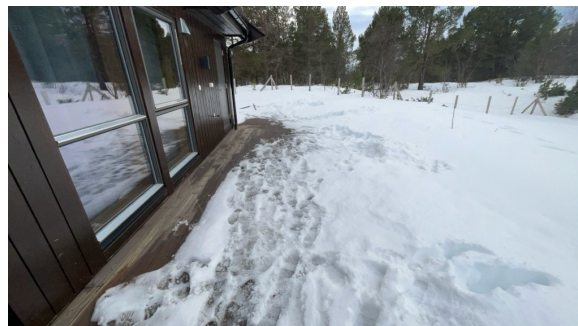
Oversiktsbilde terrasse sørvest
