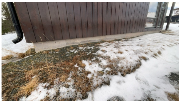
Grunnmur mot nord.
