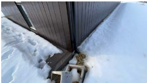
Taknedløp med utkast sørøstlig hjørne.
