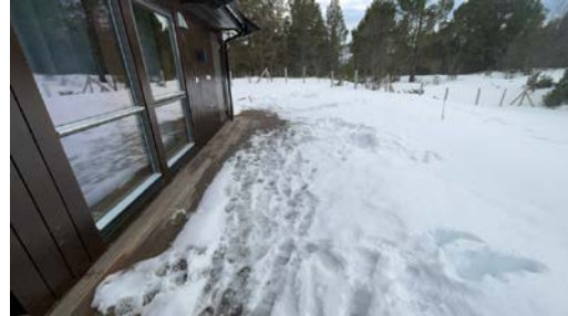
Oversiktsbilde terrasse sørvest
