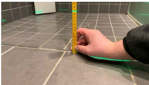
Gulv i nedsenk. Laser er plassert midt i rommet. Referanselinje 136 mm.
