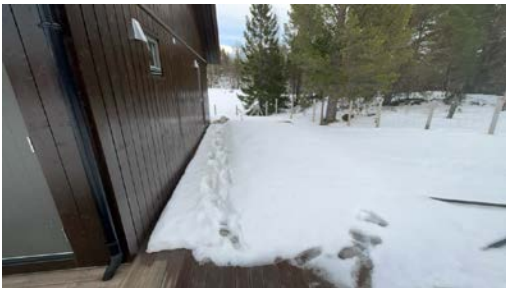
Oversiktsbilde terrasse sør
