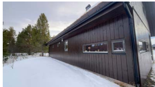
Grunnmur mot øst.
