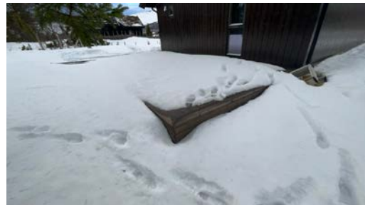
Oversiktsbilde terrasse sør
