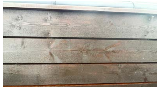
Lufting i raftkasse.
