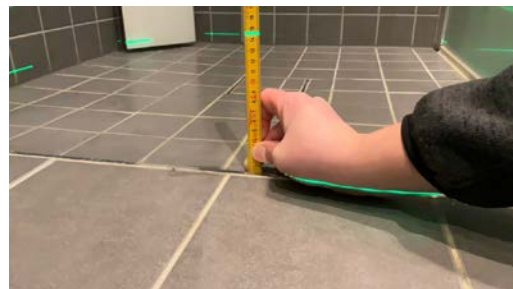
Gulv ved nedsenk. Laser er plassert midt i rommet. Referanselinje 136 mm.
