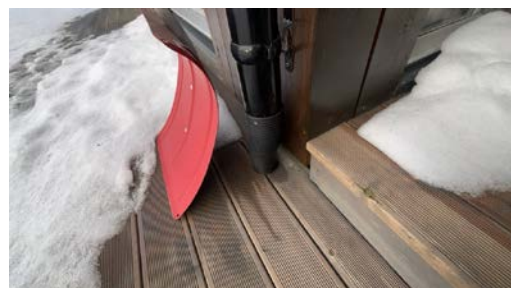
Rørøppstikk/ gjennomføring sørvestlig hjørne.
