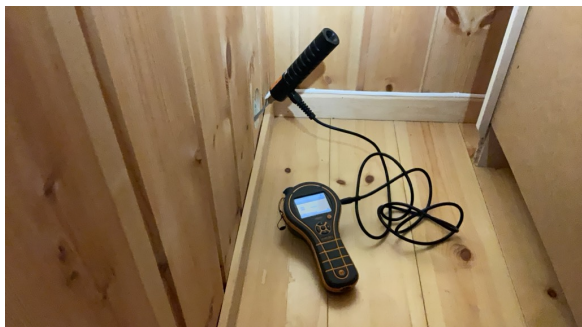
Hulltaking utført fra tilstøtende rom.
