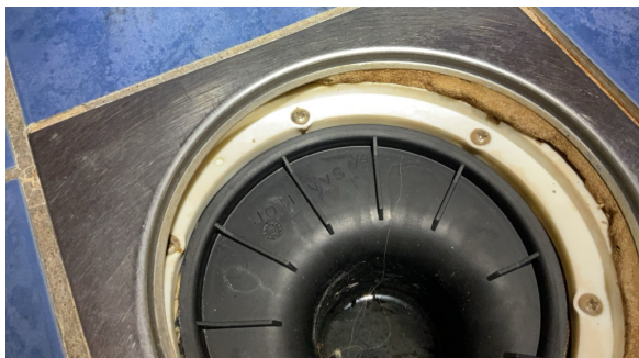
Skruer på klemring er strammet for hardt.
