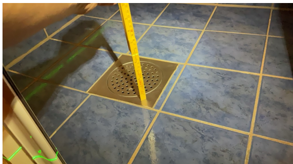
Målt fall til sluk: 5mm
