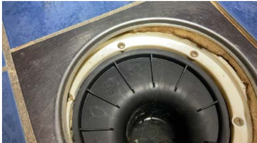
Skruer på klemring er strammet for hardt.
