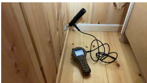
Hulltaking utført fra tilstøtende rom.
