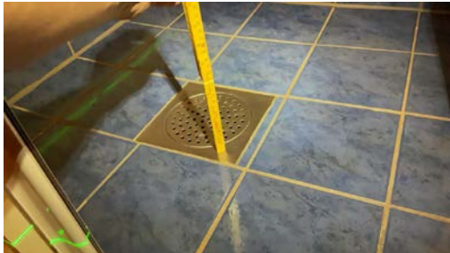
Målt fall til sluk: 5mm
