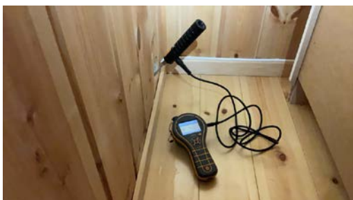
Hulltaking utført fra tilstøtende rom.
