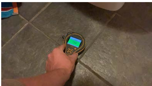
Med enkle fuktsøk ble det ikke registrert unormale verdier
