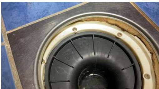
Skruer på klemring er strammet for hardt.
