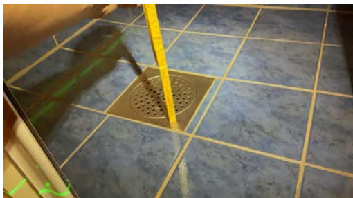
Målt fall til sluk: 5mm
