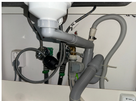
Rørapplegg i kjøkkenbenk med Waterguard
