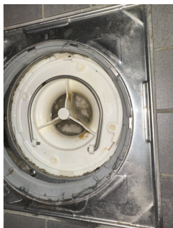
Plastsluk med klemring for membran
