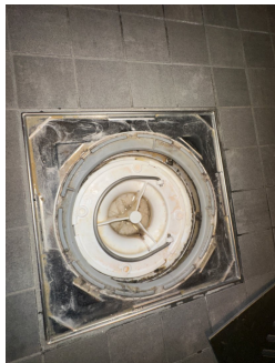
Plastsluk med klemring for membran
