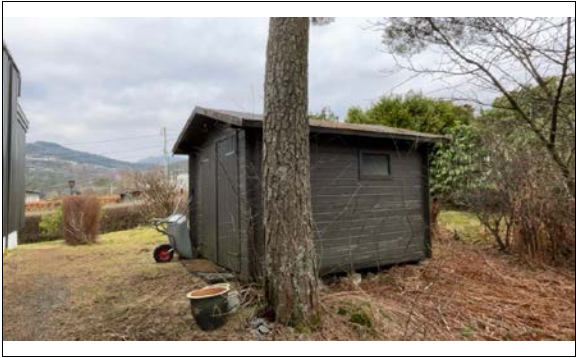
Malingsslitasje på bod.
