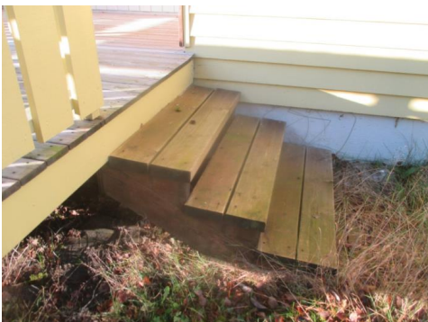
Enkel trapp til terrasse.
