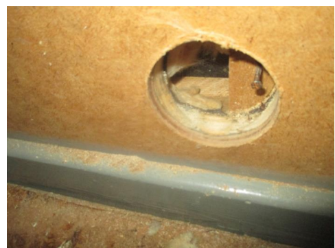
Hulltaking i fra vindfang.
