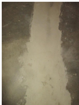
Deler av avløpsrør har vært byttet i kjellergulvet.
