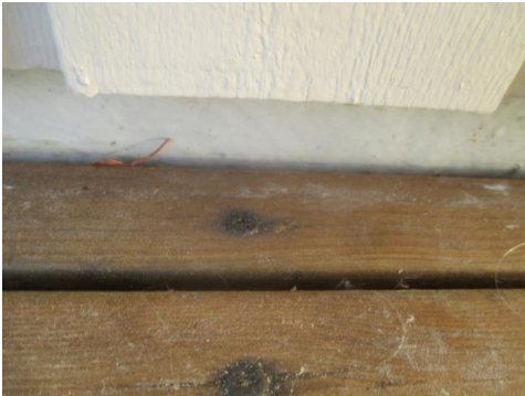
Noe av undertekking av glassfiber.
