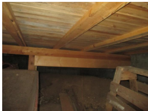
Deler av krypkjeller.
