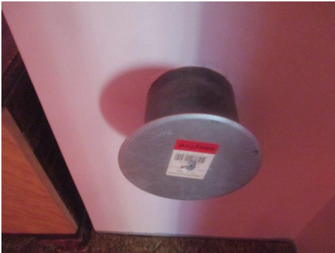
Et ildsted er tatt bort på loftet.
