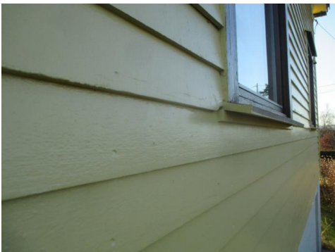
Deler av kledningen med tilhørende belistninger.
