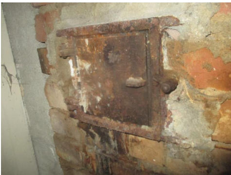
Sotluke i grovkjeller.
