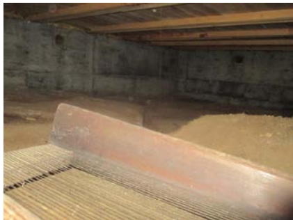
Ligger en del løse masser.
