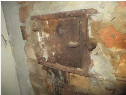
Sotluke i grovkjeller.
