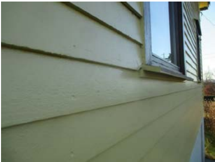
Deler av kledningen med tilhørende belistninger.
