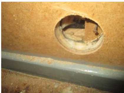
Hulltaking i fra vindfang.
