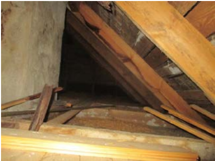
Deler av takkonstruksjonen.
