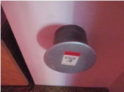
Et ildsted er tatt bort på loftet.
