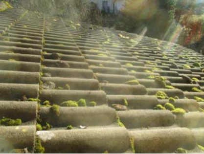
Tilbygget del sett i fra loftet.
