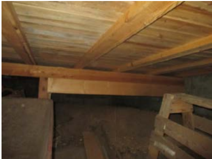
Deler av krypkjeller.
