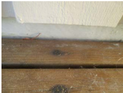
Noe av undertekking av glassfiber.
