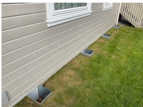
Ventilasjon i grunnmuren
