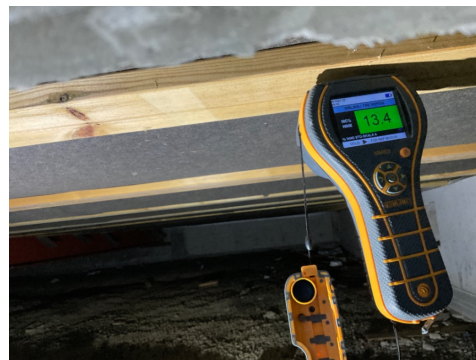
Fuktmåling i kryp kjeller
