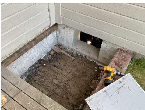
Inspeksjonsluke under tralleverk
