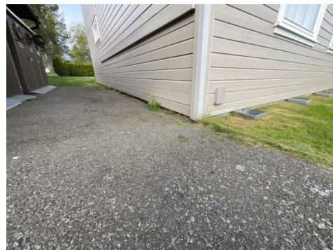
Bordkledning tett på terreng
