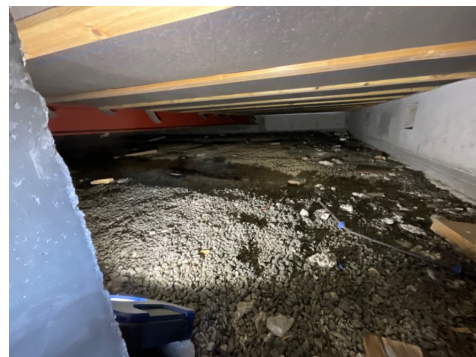
Kryp kjeller sett fra inspeksjonsluke
